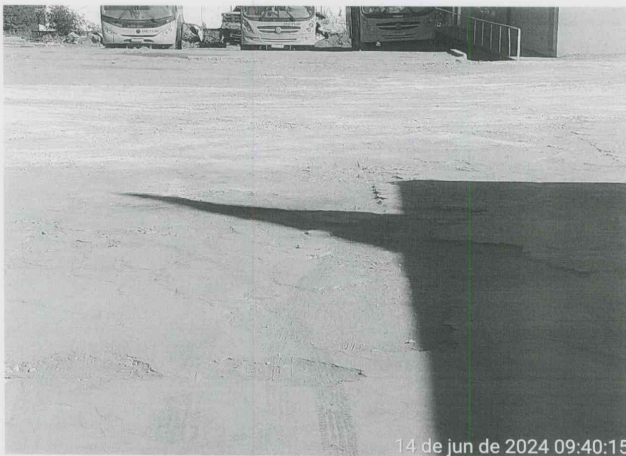
IMAGEM -1 Imagem do local , observado áreas de deterioração.
